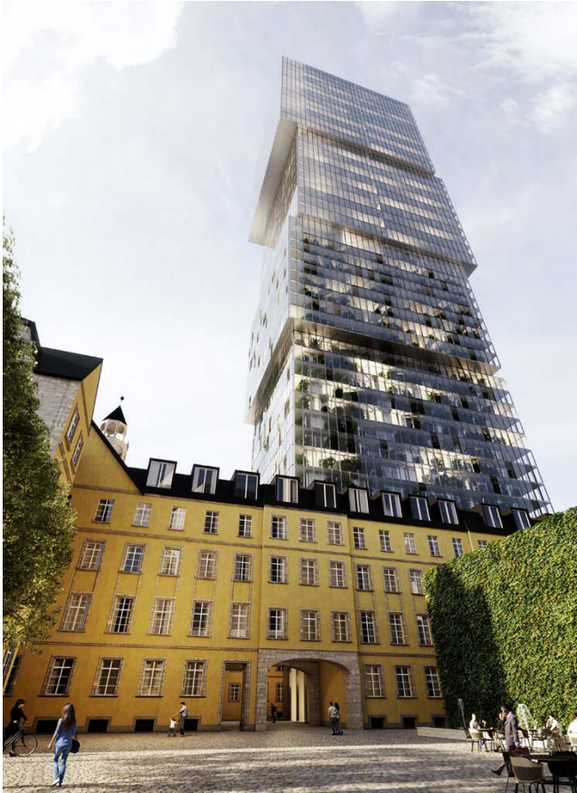
Blick auf den Turm / view of the tower
