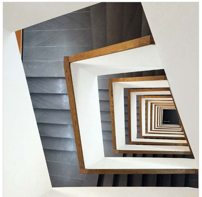
Saniertes Treppenhaus / refurbished staircase
