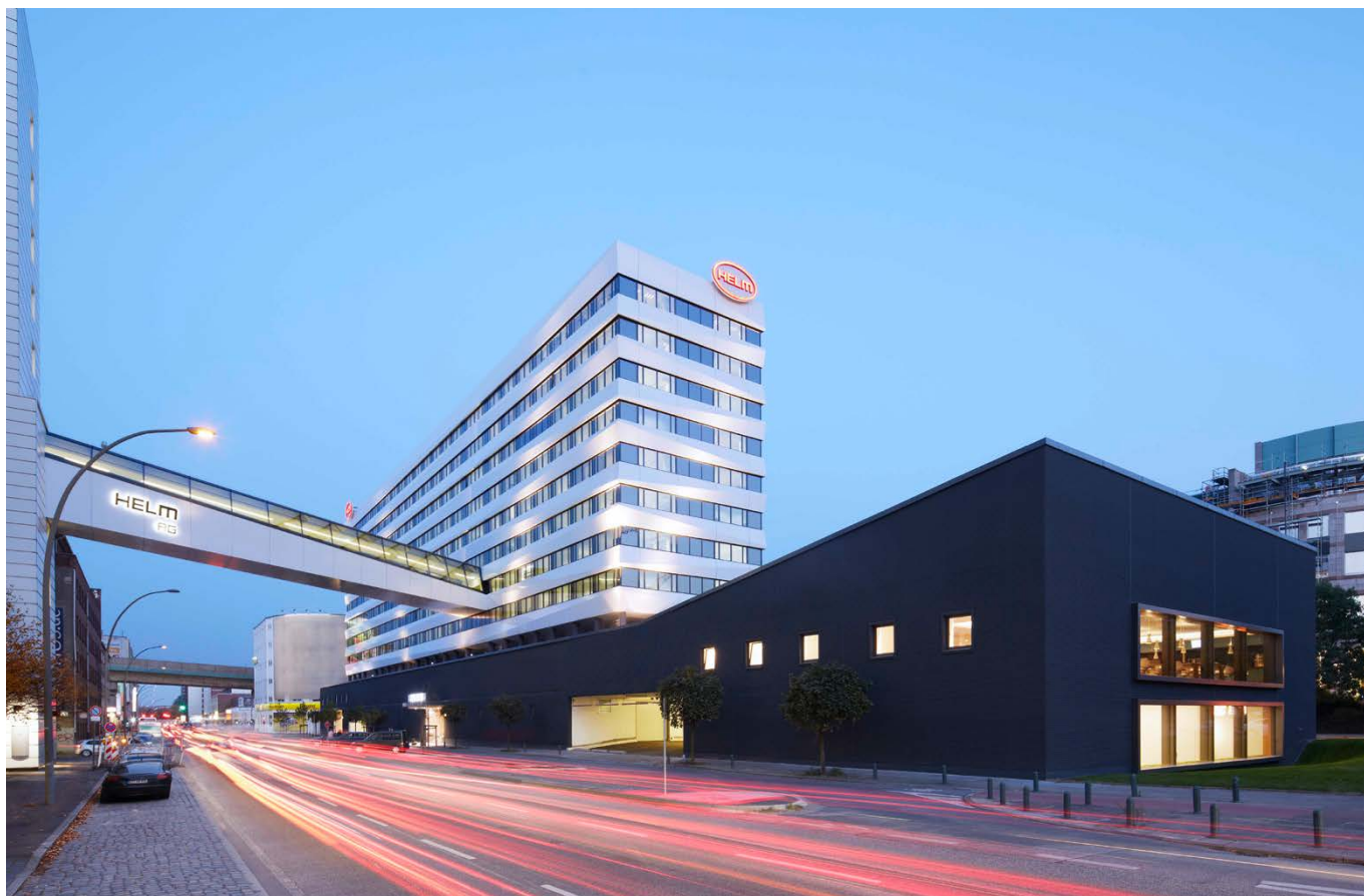
Brücke Nordkanalstraße/ bridge Nordkanalstraße
