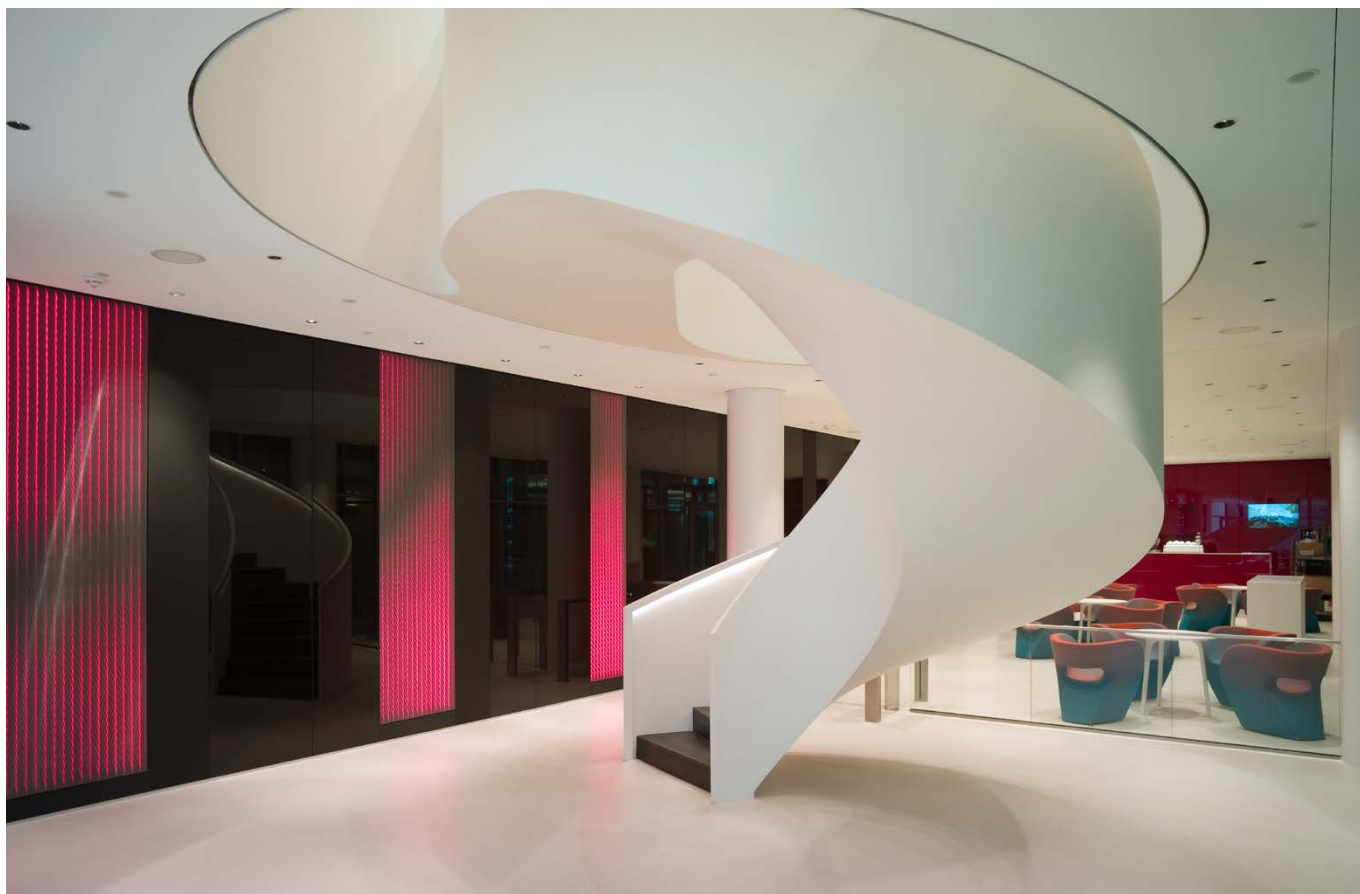
Freistehende Wendeltreppe / freestanding spiral staircase
