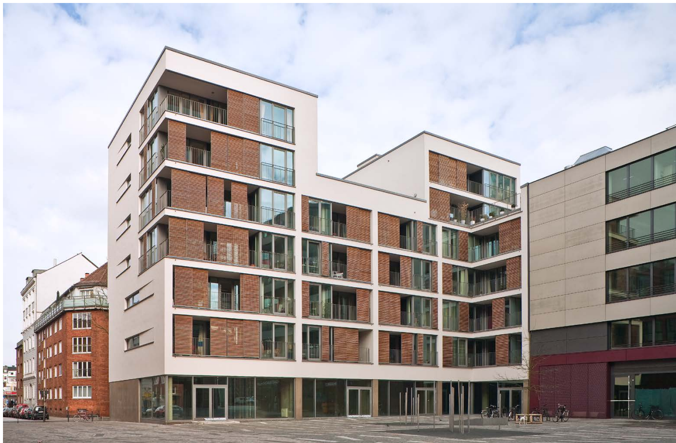
Quartiersplatz / main square
